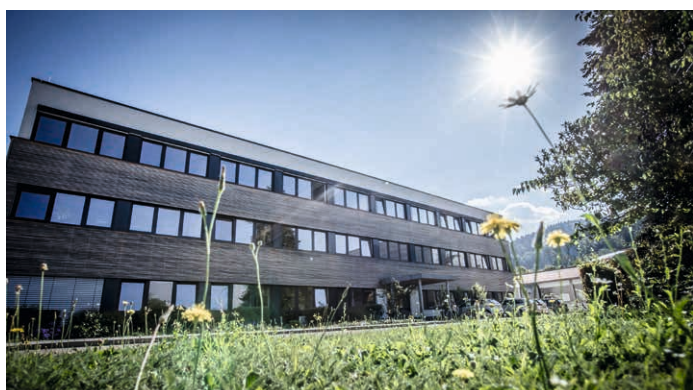
Modułowy budynek administracyjny siedziby firmy w Waldkirch można łatwo zdemontować w celu przeniesienia do parku przemysłowego Inried i zintegrować z nowym budynkiem.
