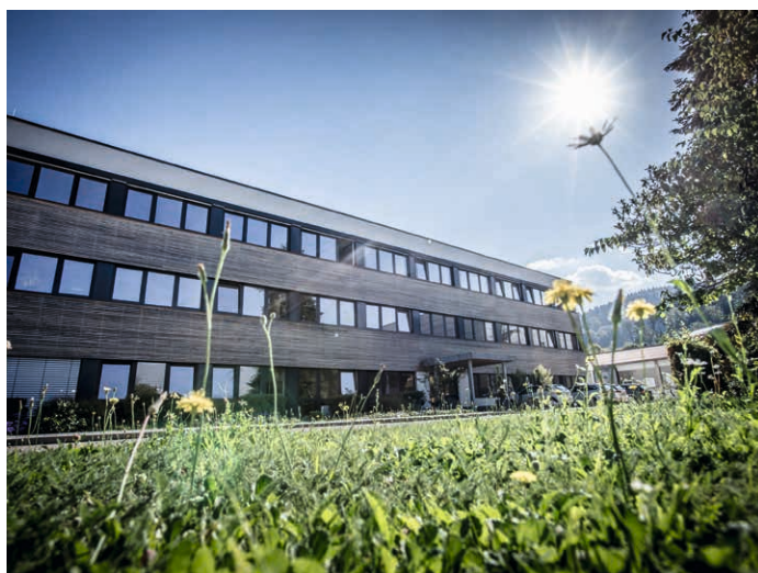
Den modulære administrationsbygning ved hovedkvarteret i Waldkirch kan let skilles ad til flytningen til erhvervsområdet Inried og integreres i nybyggeriet.
