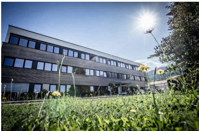
Das modulare Verwaltungsgebäude der Firmenzentrale in Waldkirch kann für den Umzug ins Gewerbegebiet Inried einfach abgebaut und in den Neubau integriert werden.
